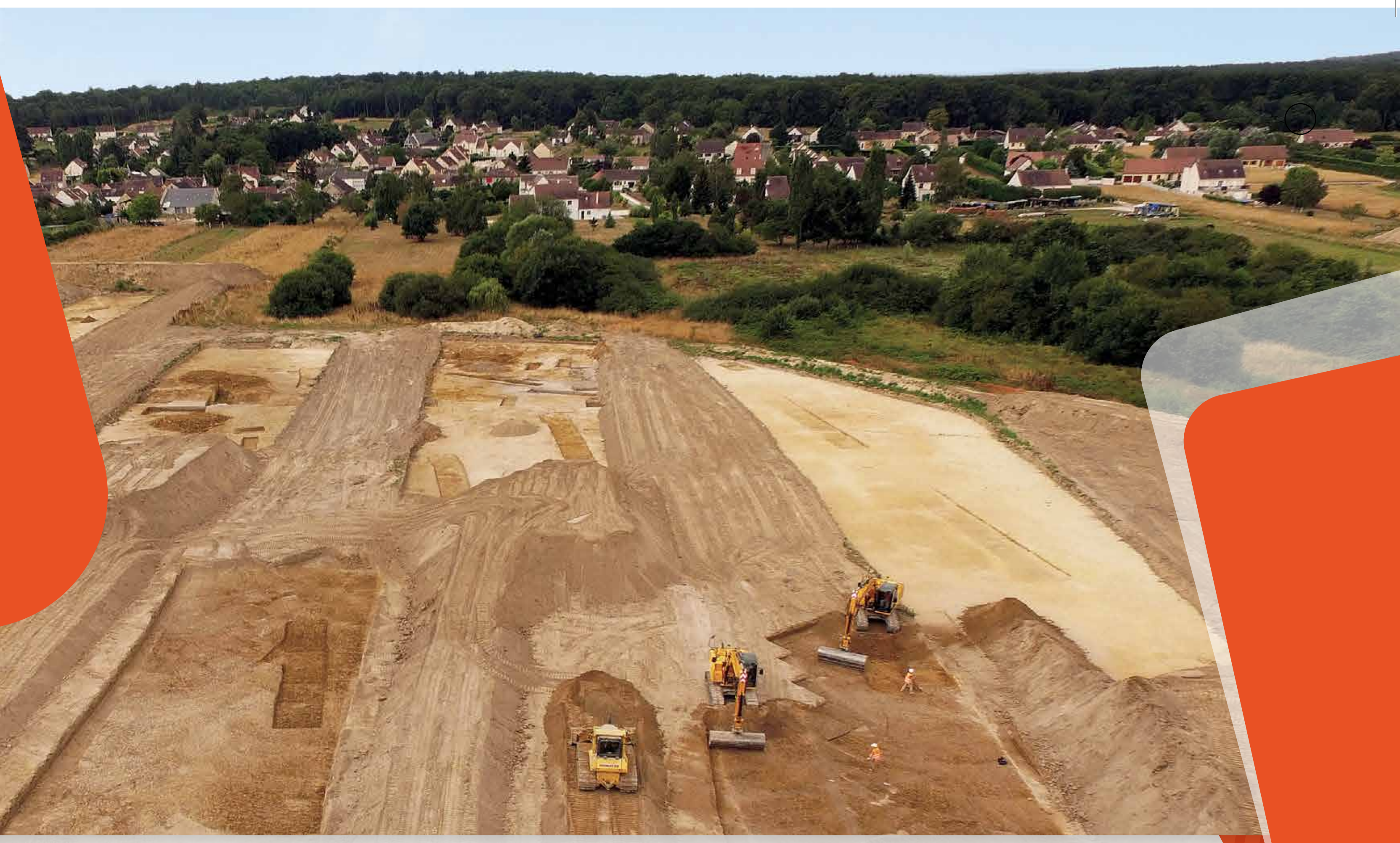
Décapage de 25 hectares de terre végétale sur le site d'Appoigny (89) - Les Bries, en 2015 (© Pyxeos pour Archeodunum SAS).
