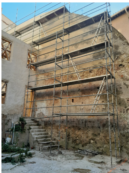
Vue du grand mur échafaudé séparant les parcelles. La partie en moyen appareil ancien est située de part et d'autre du premier platelage. © Archeodunum SAS.
