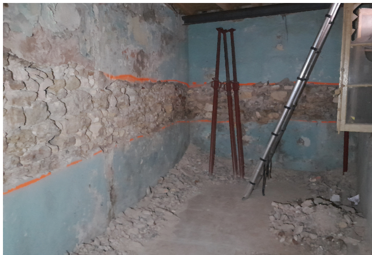
Exiguïté de l'immeuble triangulaire du 1 rue du Poirier, et vue des sondages ouverts dans les parements de son rez-de-chaussée. © Archeodunum SAS
