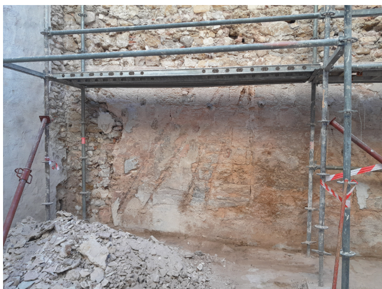
Vue du grand mur échafaudé séparant les parcelles. La partie en moyen appareil ancien est située de part et d'autre du premier platelage. © Archeodunum SAS.
