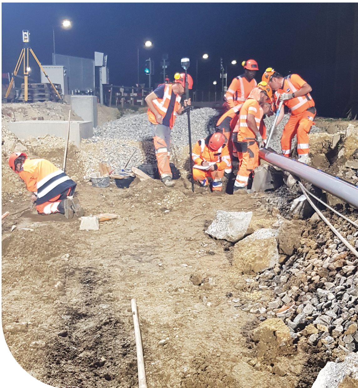
Intervention nocturne d'urgence sur la ligne de chemin de fer Chavornay-Orbe (Vaud), ou quand ouvriers et archéologues unissent leurs forces. © Archeodunum SA.
