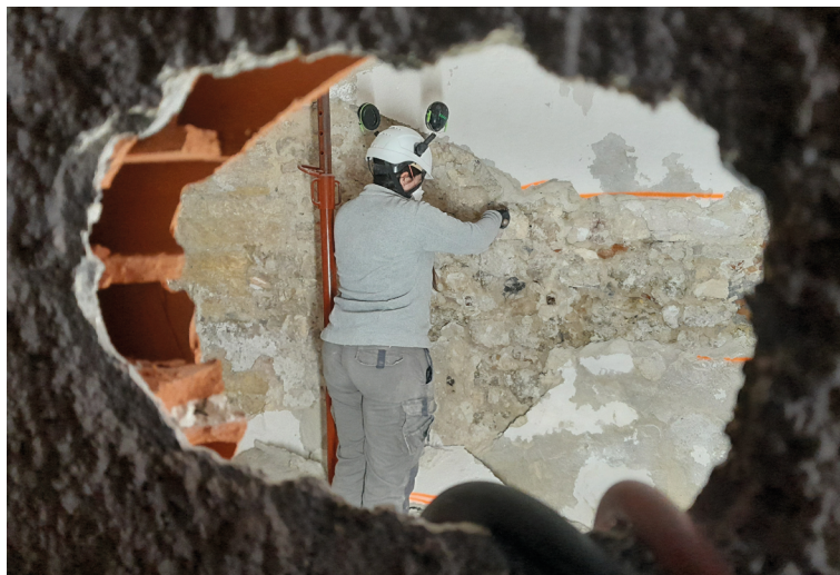
Étude en cours des parements internes de l'immeuble du 3 rue du Poirier par Mylène WASYLYSZYN. © Archeodunum SAS
