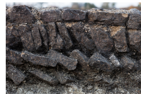
Détail de hérisson de fondation
