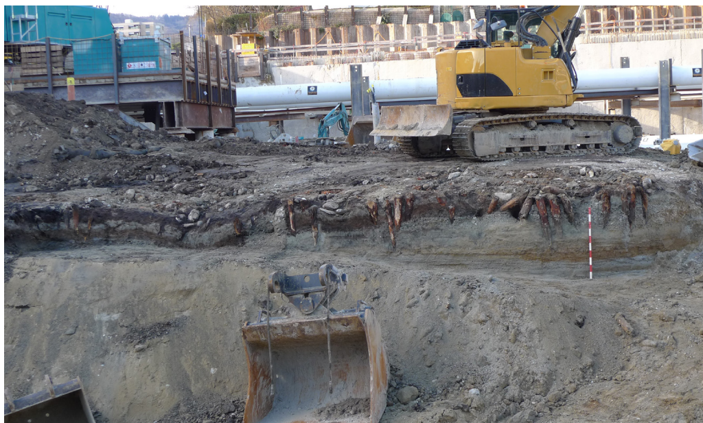
Fig. 4. Vue en coupe de l'aménagement de pieux St 17 et du substrat naturel constitué de litages sableux. Une couche tourbeuse est visible au sommet des sables lacustres.
