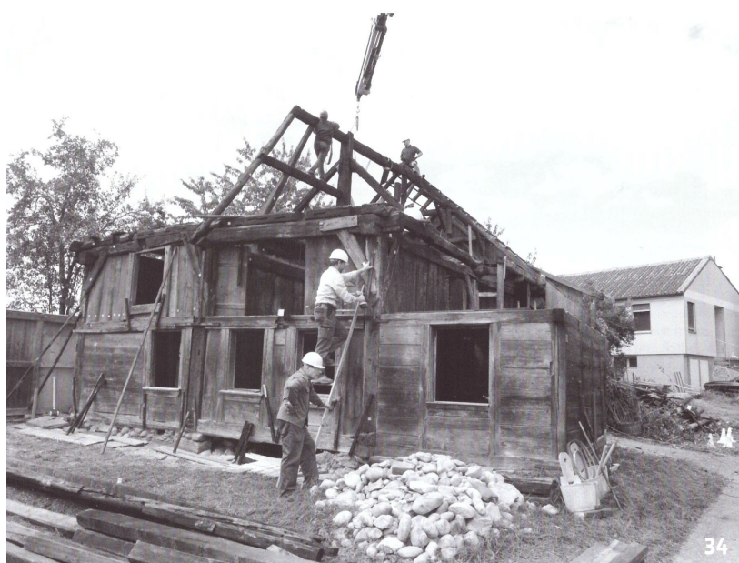
Fig. 34. Exemple de construction en bois sur radier de galets et boulets. Les parois sont constituées de planches verticales insérées et fixées par des poutres verticales. 15 e /17 e siècle. Tiré de Herrmann 2020, fig. 70, p. 181.
