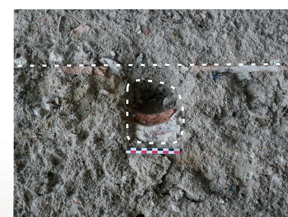
3. Négatif de bois dans une paroi en pisé.
