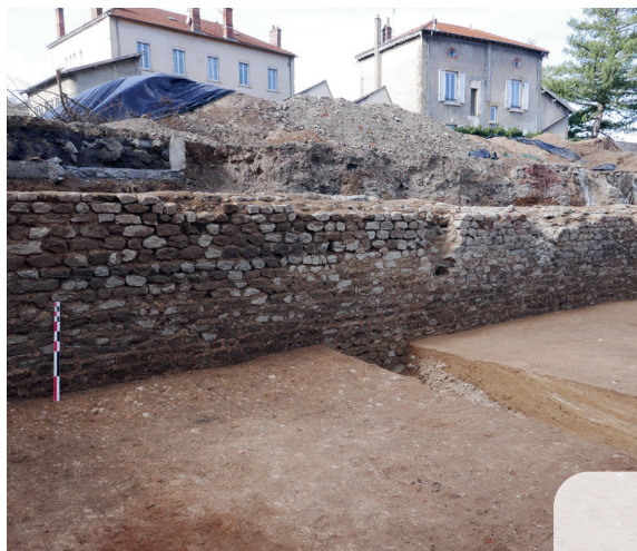
Fig. 3 : Mur de terrasse.
