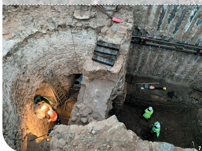
Fig. 4 : À l'aide d'une pelle mécanique, dégagement des fondations de la courtine du XIII e siècle - Fig. 5 : Plan général de Montbrison avec la localisation de l'étude archéologique - Fig. 6 : Plan phasé des principaux vestiges - Fig. 7 : À gauche, intérieur de la tour semi-circulaire ajoutée au XV e siècle
