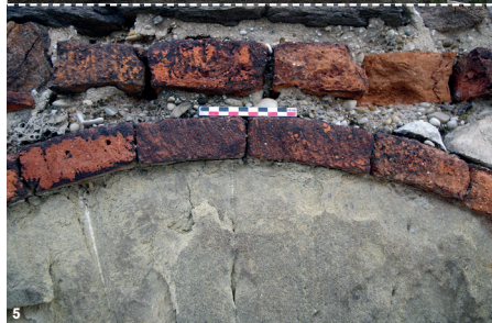
Fig. 4 : Partie nord-est de l'église, après restauration. On y distingue les différents types de pierre. - Fig. 5 : Mortier sableux entre les pierres de taille de l'arc et mortier caillouteux dans l'appareil du mur. - Fig. 6 : Pierre sommitale du bras sud du transept.
