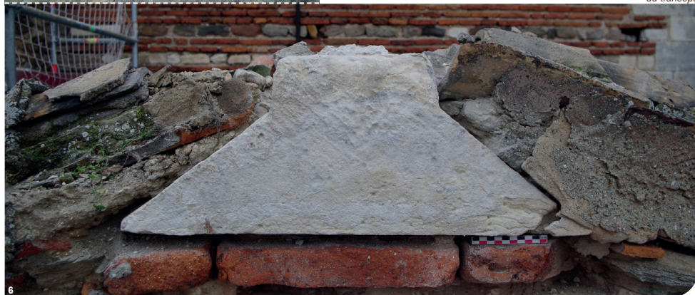
Fig. 4 : Partie nord-est de l'église, après restauration. On y distingue les différents types de pierre. - Fig. 5 : Mortier sableux entre les pierres de taille de l'arc et mortier caillouteux dans l'appareil du mur. - Fig. 6 : Pierre sommitale du bras sud du transept.
