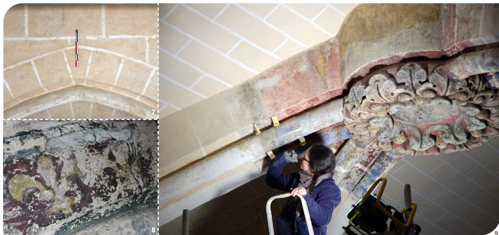
Fig. 7 : Décor de faux-appareil tracé en blanc sur le mortier beige. - Fig. 8 : Décor polychrome héraldique de fleur de lys dorée sur une clef de voûte. -
