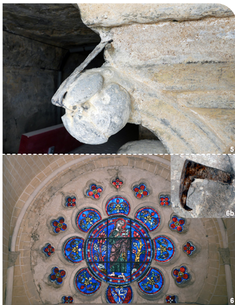
Fig. 5 : Réparation d'un chapiteau à l'aide d'une pièce métallique.
