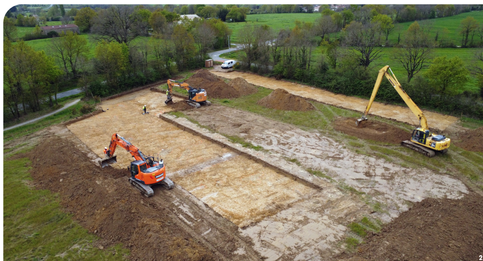
Fig.2 : Au début de la fouille, le décapage des terres mobilise de nombreux engins.
