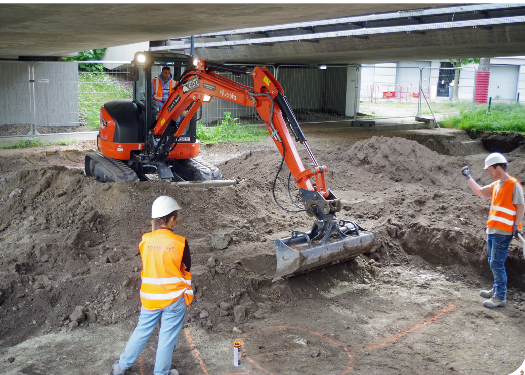
Fig.9 : Décapage quelques centimètres sous le tablier du viaduc.
